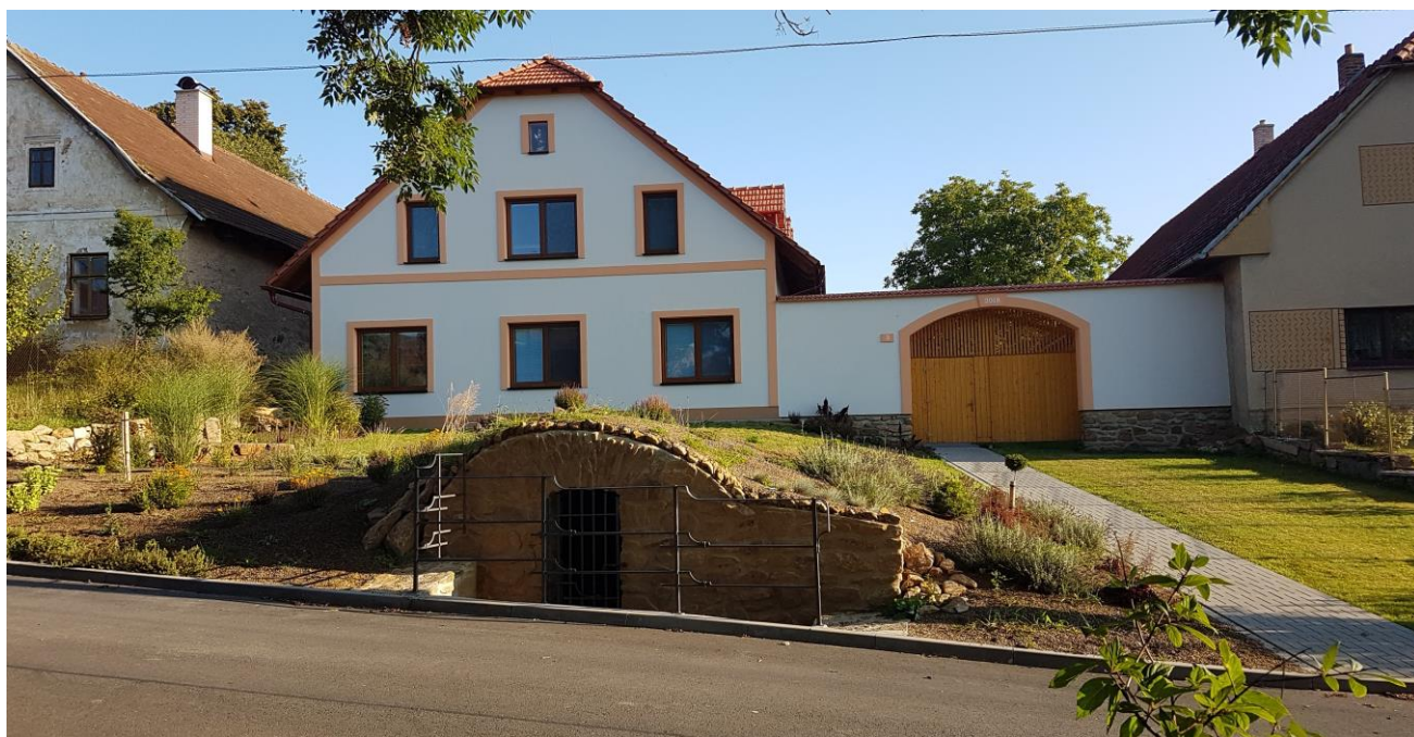
Obrázek č.3: Bytový dům č. 5
